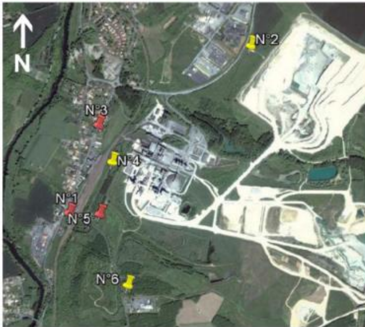
Localisation des ZER à proximité et en limite de propriété de la cimenterie (Source : Rapport de mesures de bruit ENCEM de décembre 2019)
